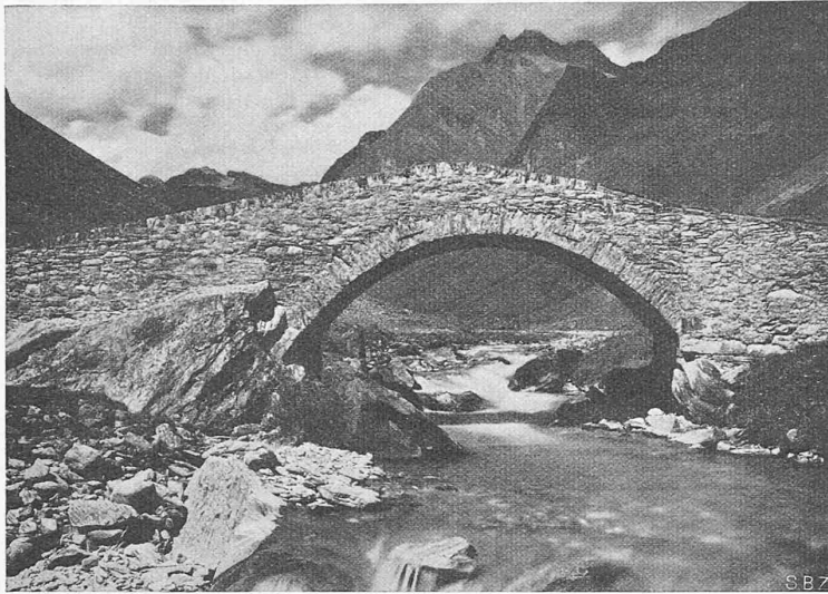
Abb. 9. Alte Brücke am Septimerpass (Graubünden). Plattiges Gestein lagerhaft verarbeitet, Rollschicht und dünne Abdeckplatte als Abschluss der Brüstung
