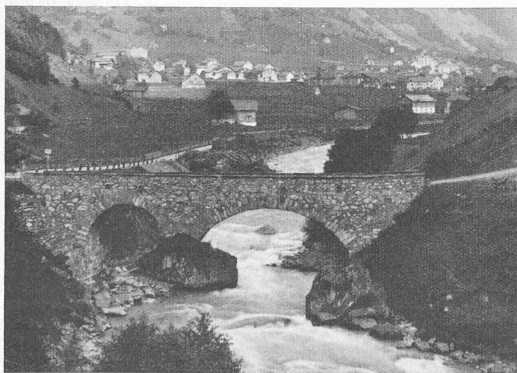
Abb. 8. Alte Sernfrücke bei Engi (Glarus). Vollkommene Einheit zwischen Bogen und Aufmauerung durch Ineinandergreifen der Steine, lagerhaftes Verarbeiten, glatte Ansichtsfläche
