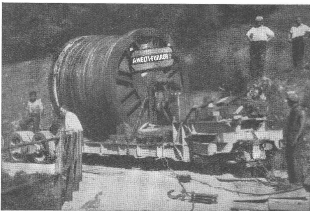
Transport der Tragseilkabel für die Säntis-Schwebbahn
