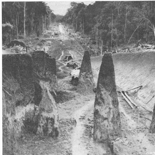
Abb. 5. Beispiel eines Einschnitts südlich Kenawang in trockenem Boden. — Gesamt-Aushubkubatur 470 000 m 3
