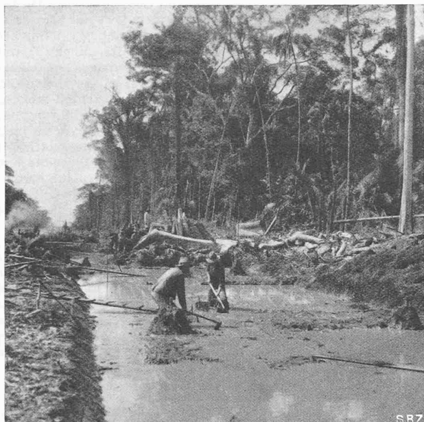
Abb. 6. Seitlicher Aushub für Dammschüttung in schlammigem Boden, Gesamtlänge hiervon 10 km, Kubatur 130 000 m 3
