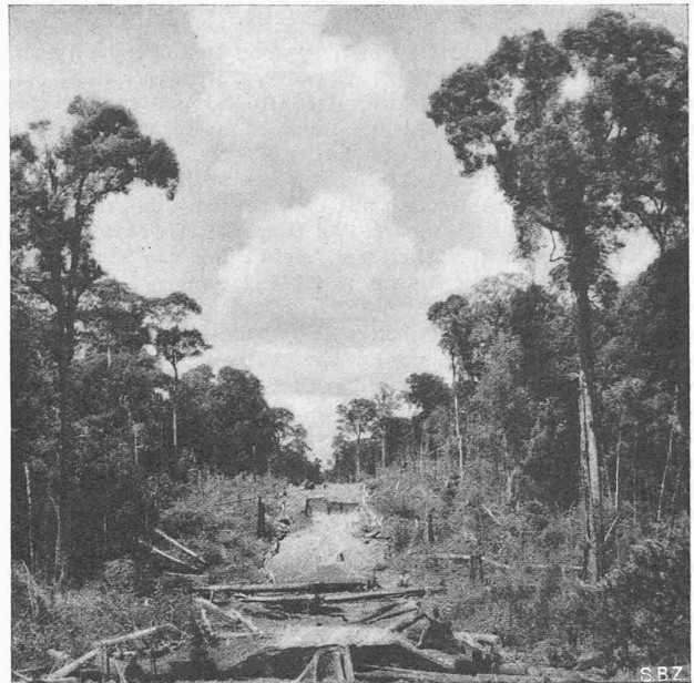
Abb. 7. Beginn der Planierung in trockenem Boden zwischen Lilin und Tamiang
