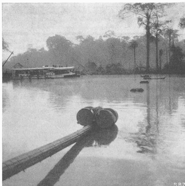
Abb. 11. Legen der isolierten Oelleitung durch den Lalangfluss, auf dessen Sohle sie von den Schwimmern abgesenkt wird
