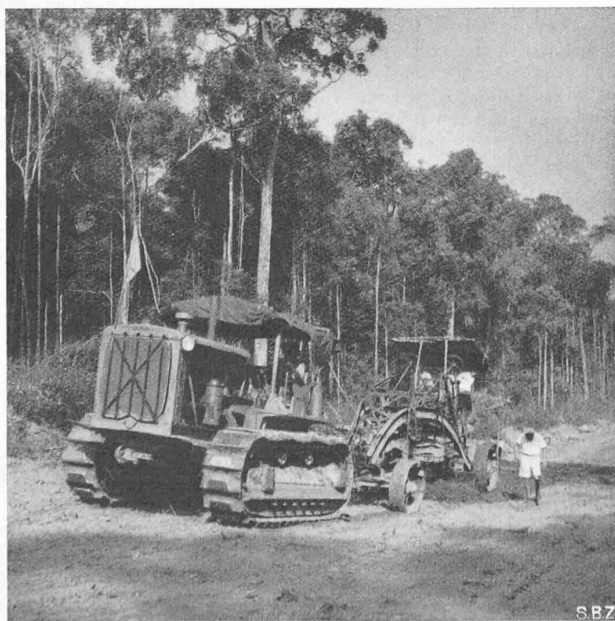
Abb. 8. Traktor schleppt den «Grader», die Planierungsmaschine; auf diese Weise sind 55 km des Planums hergerichtet worden
