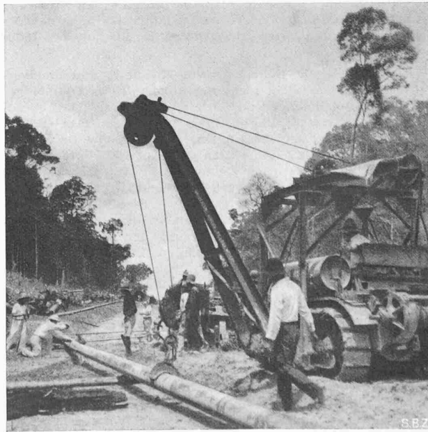
Abb. 9. Traktor mit seitlichem Ladekran bei der Rohrmontage, Vorstrecken der geschweissten Leitung
