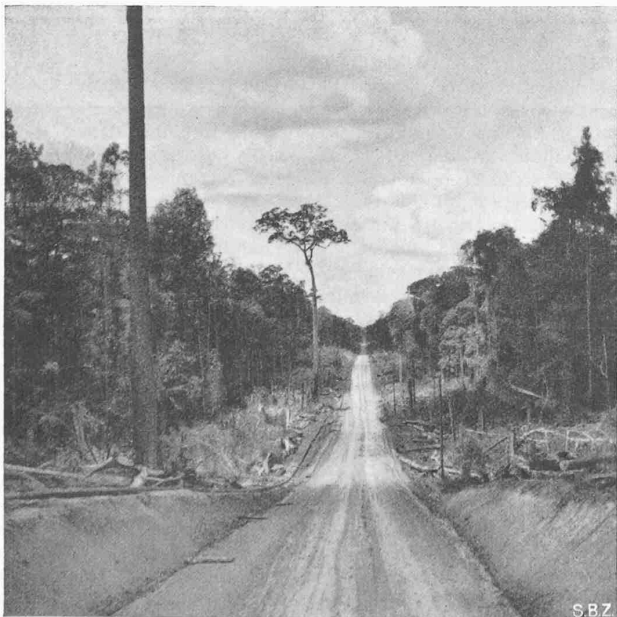
Abb. 10. Eine 5½ km lange Gerade «über Berg und Tal» im Hügelgebiet bei Tamiang; links die Rohrleitung
