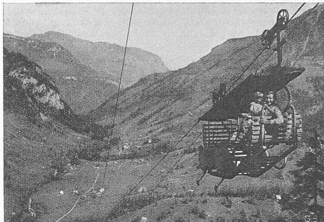
Kleinseilbahn für Personenbeförderung, mit 500 l Wasserballast und Handbremse. Mittlere Fahrgeschwindigkeit 10 bis 15 m/sec auf 370 m!
