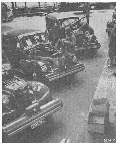
Abb. 9. Erstes Einregulieren der Motoren auf Azetylenbetrieb
