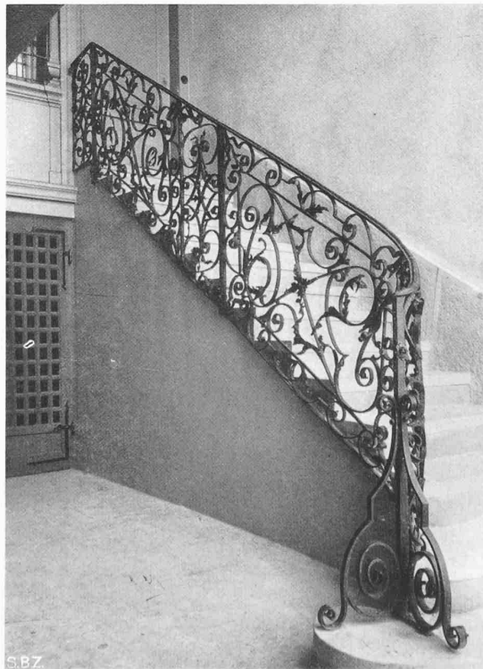
Abb. 8. Geländer am Verbindungsbau zum Gartenflügel
