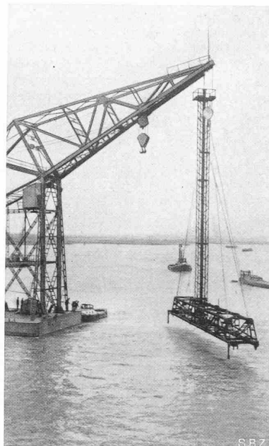
Abb. 15. Messgerät zur Kontrolle der genauen Lage der Lagerbalken. Das im Turm eingebaute Rohr dient dem Hochloten des elektrisch beleuchteten Axpunktes mittels optischem Lot
