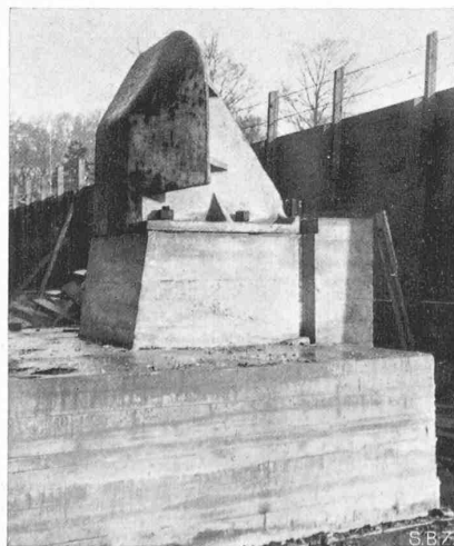
Abb. 14. Lagerstuhl am Ende des Lagerbalkens, zum Anschlag der Seitenpressen
