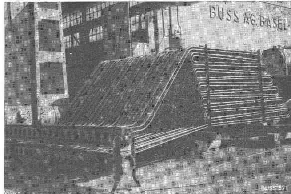
Ueberheitzer für einen Steillohrkessel 500 m<sup>3</sup>, 34 Atü, 425° C Dampf-Temperatur, Rohrschlangen in Speziallegierung
