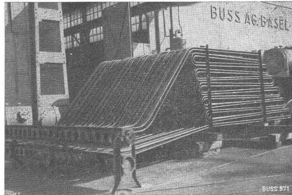
Überheitzer für einen Steillohrkessel 500 m<sup>3</sup>, 34 Atü, 425°C Dampf-Temperatur, Rohrschlangen in Speziallegierung
