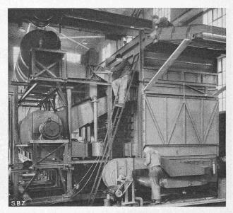
Abb. 2. Elektrischer Grastrockner BEC, von der Grasaufgabeseite Leistung 250 kg/h Trockengras, Anschlusswert total 650 kW
