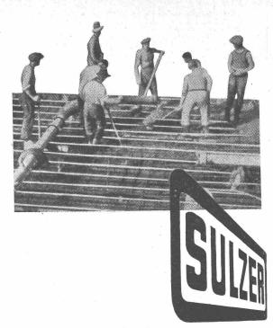
Strahlungsheizung wird hier im Rohbau verlegt
