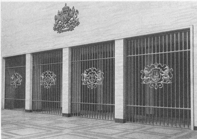
Abb. 5. Gitterabschluss der Schalterhalle
