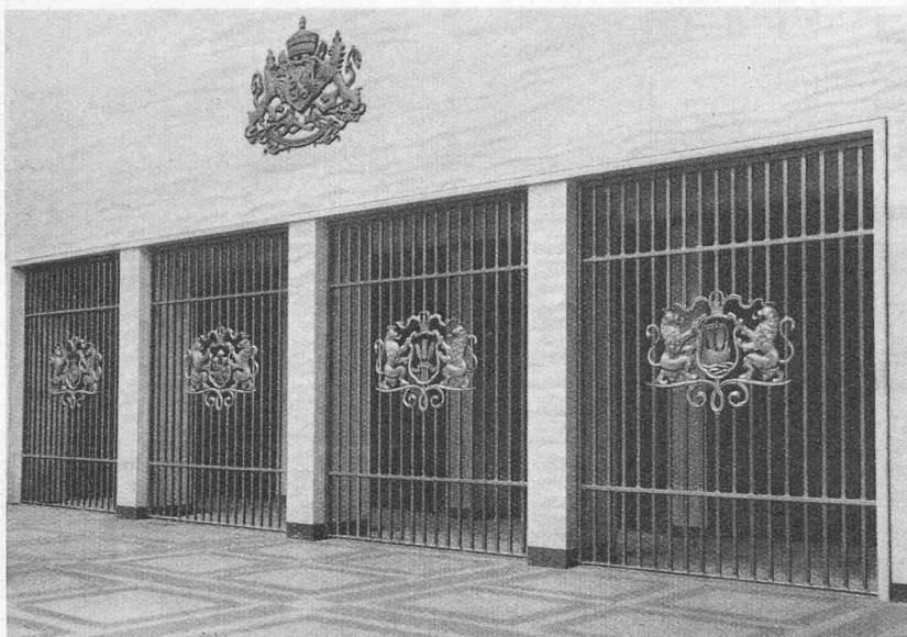
Abb. 5. Gitterabschluss der Schalterhalle
