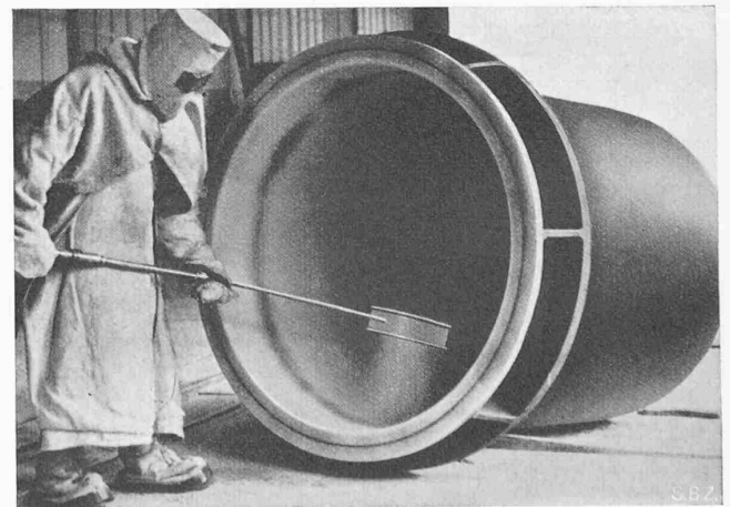
Abb. 3. Pudern eines Kessels mit hochsäurefestem Email
