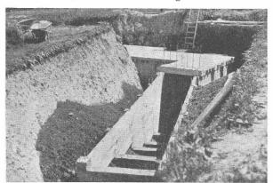
mauern an einer der Zugangsrampen, die Querschwellen, sowie die Rippen der Seiling-Decke. Der abgebildete Schutzraum für rd. 50 Personen wurde in nur zehn Tagen ausgeführt. Luftschutzbauten mit dem neuen patent. Bauelement sind erstellt worden in den Kantonen Bern, Waadt und Genf, Seiling-Decken ohne Schalung zudem in mehr als 600 Fällen aller Art. Auskunft, Voranschläge und Abgabe von Lizenzen durch Seiling, Eisenbeton, Bern.
