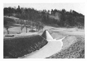
Abb. 25. Rücksichtsloser Fremdkörper im Landschaftsbild! Eine in Gefälle, Wasserführung und Kosten unspürbare, leichte S-Schwingung hätte genügt, den Bach ins Gelände einzuschmiegen
