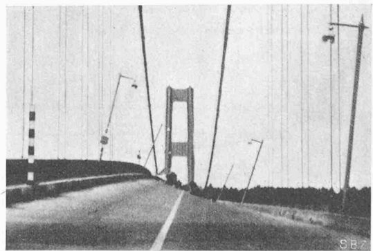
Abb. 2. Drehschwingungen der Fahrbahnplatte etwa 12 Schwingungen pro min, bis 45^\circ Querneigung
