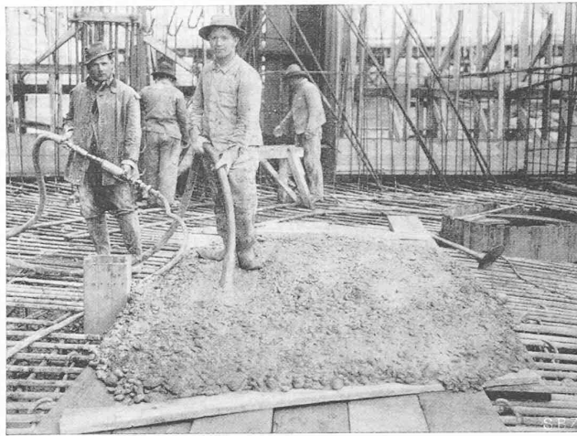
Abb. 5 und 6. Rüttelversuch an 1 m 3 Beton P 250 (Setzmass 1 bis 1,5 cm, Ausbreitmass 25 bis 30 cm). Durch Rütteln während ½ min hat sich die erdfuchte Konsistenz (links) in die plastische (rechts) umgewandelt
