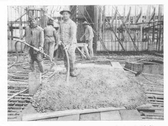
Abb. 5 und 6. Rüttelversuch an 1 m³ Beton P 250 (Setzmass 1 bis 1,5 cm, Ausbreitmass 25 bis 30 cm). Durch Rütteln während ½ min hat sich die erdfeuchte Konsistenz (links) in die plastische (rechts) umgewandelt
