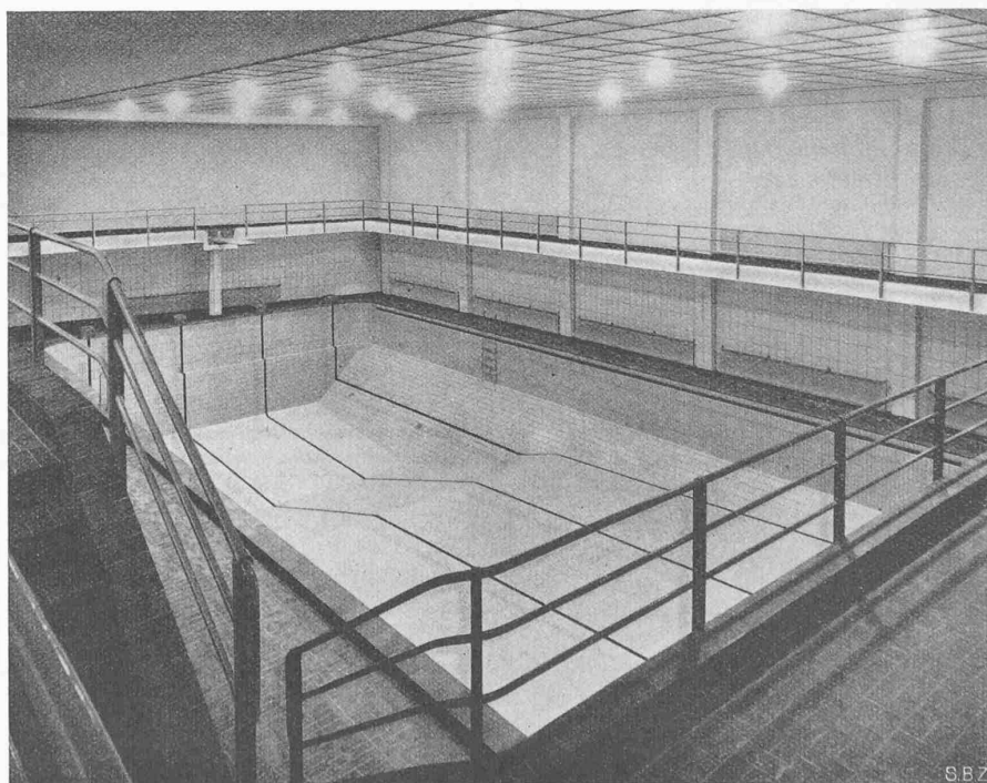
Abb. 10. Das entleerte Becken bei künstlichem Licht, links Ausgang zur Liegegalerie
