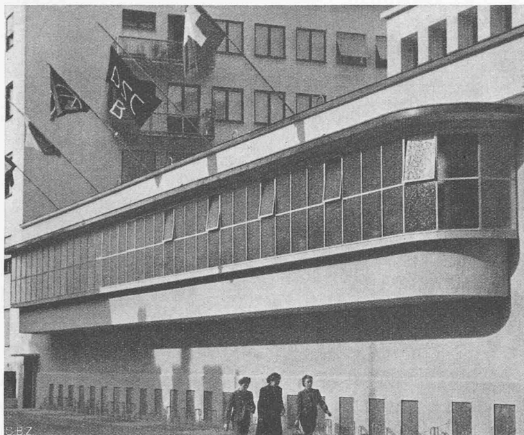
Abb. 7. Neubau-Teil des Bades an der Maulbeerstrasse
