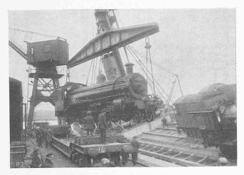
Abb. 1. Anhebung der Last mittels eines Schiffs-Hebebaums
