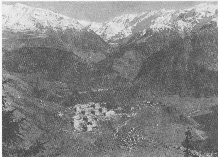
Abb. 1. Gesamtbild des Villaggio Sanitoriale di Sondalo im Veltlin, aus Südwest
