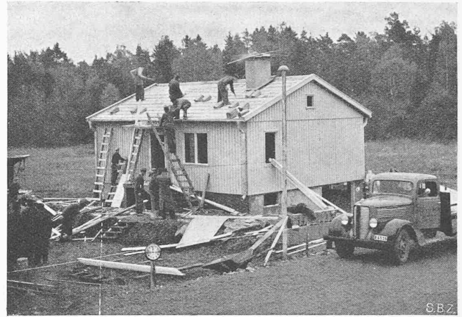
Abb. 12. 12 h: Dachdeckung, Heizung wird probiert
