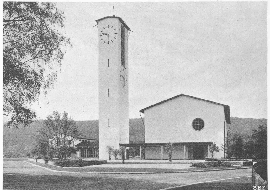
Abb. 4. Hauptansicht aus Norden, links im Hintergrund das Pfarrhaus
