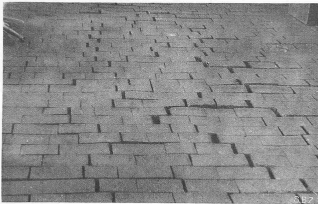
Abb. 3. Holzpfaster in Sand verlegt. Die Klötzli sind zu niedrig, sie haben jeden Halt verloren
