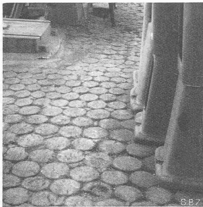
Abb. 1. Alter Holzpfasterboden aus Rundlingen
