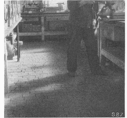
Abb. 4. Holzpfasterboden mit E-K imprägniert und mit Fugen in Sand verlegt
