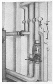
Abb. 5. Mobila-Pumpe, eingebaut in Rücklaufstrang einer Zentralheizung
