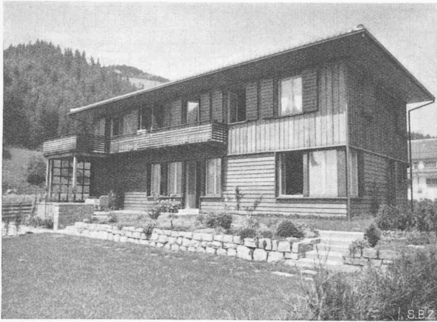
Abb. 2. Arzthaus in Trubschachen, aus Süden
