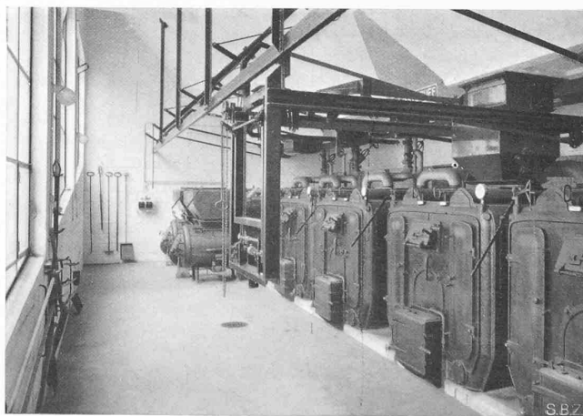
Abb. 20. Heizung mit Beschickungs-Laufkran verbunden mit Waage
