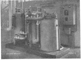
Niederspannungs-Elektrokessel mit Kleinspeicher 3000 kW, 500 V. 50 Per/s.
