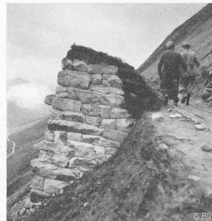
Abb. 1. Vorbildliche Trockenmauer als Lawinerverbauung an der Oberalp
