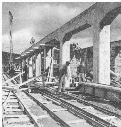
Abb. 3. Eisenbetonrahmen zwischen Strasse und Bahn, rechts Aussenwände der Galerie
