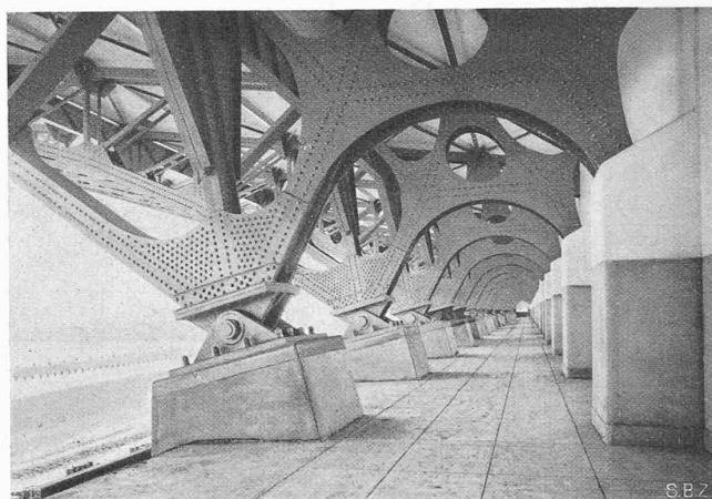
Abb. 5. Stützlager (im 3. Obergeschoss) der Kragträger für das Dach
