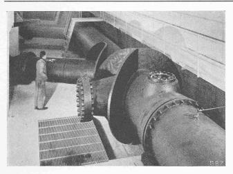
Abb. 16. Verteilringleitung im Etzelwerk der SBB für 50 at Betriebsdruck. Im Hintergrund schiefwinklige Abzweigstutzen der Turbinen-Anschlüsse, vorn rechtwinklige Abzweigung für spätern Speicherpumpenanschluss; alle mit Sulzerkragen
