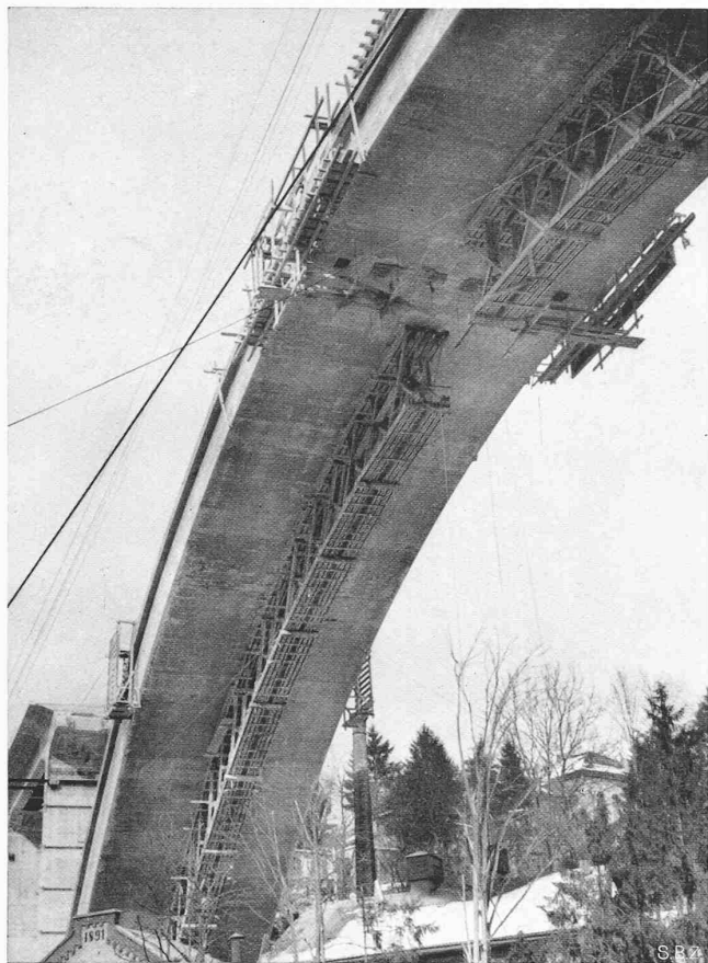
Abb. 47. Schlusszustand beim Abbruch des Lehrgerüsts, das durch Verankerungsschrauben mit dem Gewölbe verbunden war, dies auch zur Sicherung der Verbundwirkung von Holz und Beton
