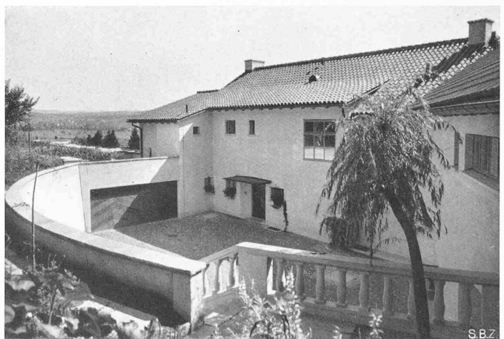
Abb. 6. Bergseitiger Hof, gegen Süden gesehen, Hauseingang, Garagetor
