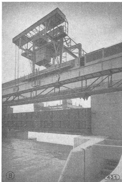
Wehranlage Klingnau, Ansicht von Oberwasserseite mit Dammbalkenkränen.
