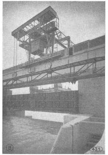
Wehranlage Klingnau, Ansicht von Oberwasserseite mit Dammbalkenkranen.
