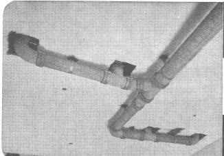
Eternit-Installationsrohre sind rasch verlegt, nachträgliche Anschlüsse sind, da muffenlos, leicht ausführbar; schallhemmende u. nichtrostende Wandungen
