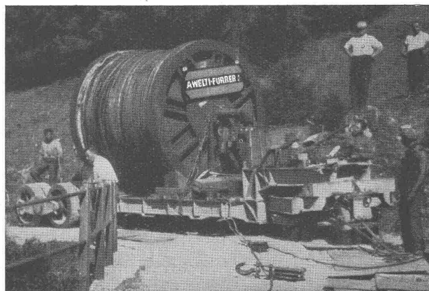
Transport der Tragseilkabel für die Säntis-Schwebebahn
