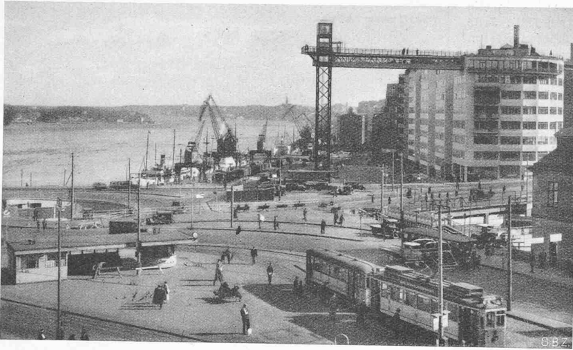
Abb. 6. Haus der Kooperativa am Süden des «Slussen» in Stockholm. Der Lift «Katrinahissen» führt auf die Höhe des Dachgeschosses (mit Restaurant in der Brücke), von wo aus nach rechts eine weitere Brücke auf das stark ansteigende Gelände von Södermalm hinüberführt TEXT SIEHE SEITE 54
