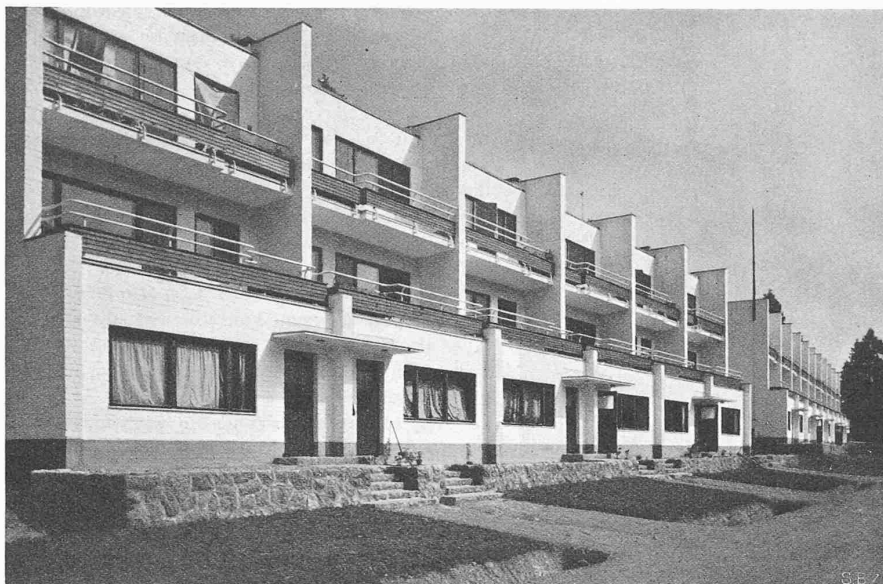
Abb. 22. Westseite der gestaffelten dreigeschossigen Wohnungsreihe Architekt ALVAR AALTO, Helsinki
