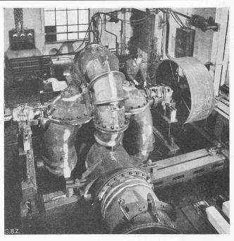
Abb.1. Doppelt beaufschlagte Sulzer-Limax-Zentrifugalpumpe auf dem Versuchstand in Winterthur. Die Pumpe fördert 3330 l/s auf eine manometrische Förderhöhe von 24 m bei 485 U/min und 1190 PS Kraftbedarf
