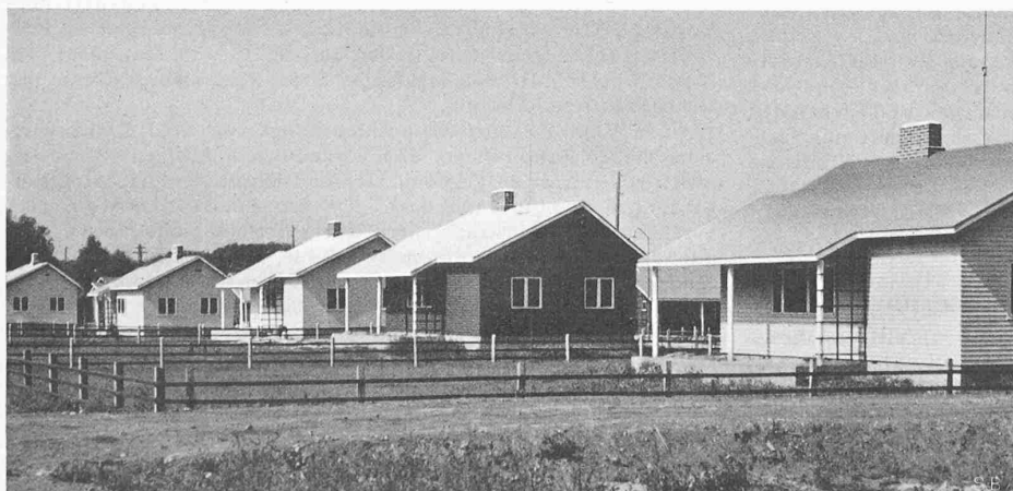
Abb. 24. Einfamilien-Holzhäuser aus fabrikfertigen Elementen, aus Südwesten
