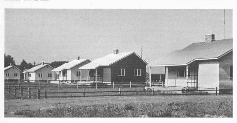
Abb. 24. Einfamilien-Holzhäuser aus fabrikfertigen Elementen, aus Südwesten
