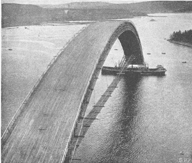
Abb. 7. Das Lehrgerüst der Sandöbrücke beim Einfahren
