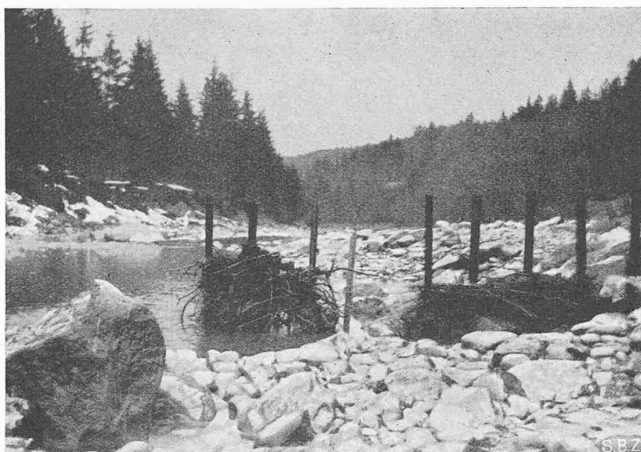
Abb. 16. Sporen aus eingerammten Eisenbahnschienen
