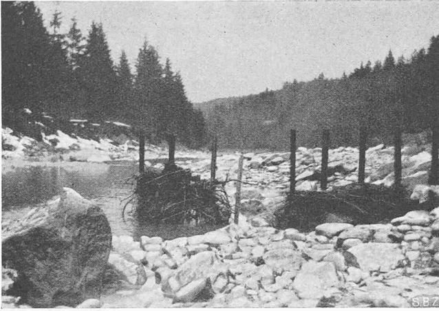
Abb. 16. Sporen aus eingerammten Eisenbahnschienen
