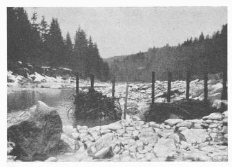
Abb. 16. Sporen aus eingerammten Eisenbahnschienen
