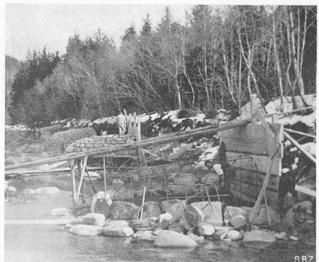
Abb. 14. Armieren und Verkleiden von Schildkröten
