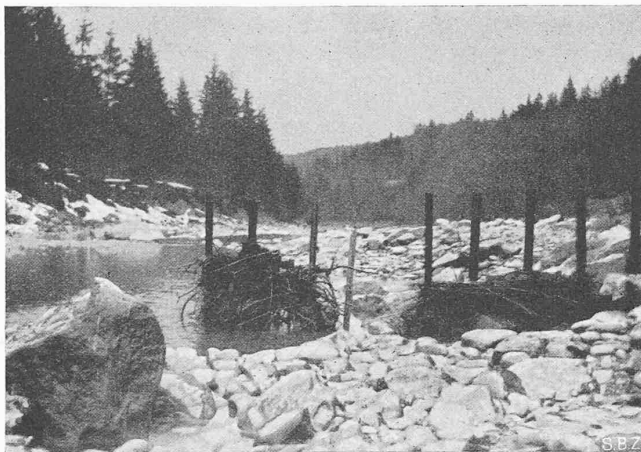
Abb. 16. Sporen aus eingerammten Eisenbahnschienen
