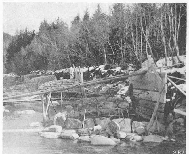
Abb. 14. Armieren und Verkleiden von Schildkröten
