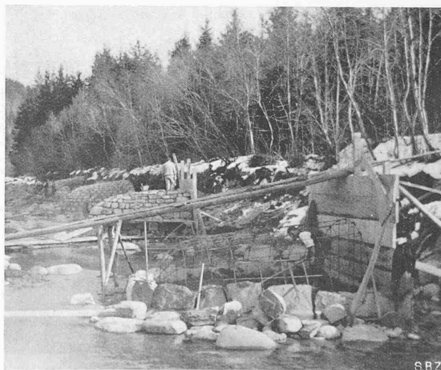
Abb. 14. Armieren und Verkleiden von Schildkröten
