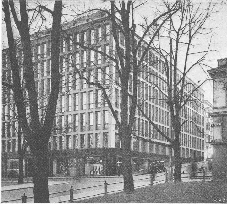
Abb. 5. Kontorgebäude Lassila & Tikanojas, Helsinki. Arch. Prof. J. S. Sirén
