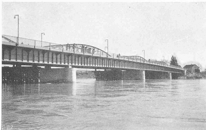
Abb. 3. Neue Strassenbrücke über die Save bei Zagreb, erbaut 1938/39 Geschweisster durchlaufender Vollwandbalken 54,6 + 2 \times 55,0 + 54,6 m
