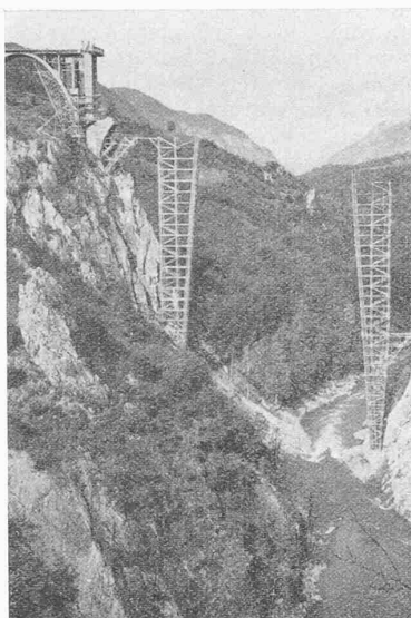
Abb. 8 (links). Die 100 und 130 m hohen Gerüsttürme der Tara-Brücke
