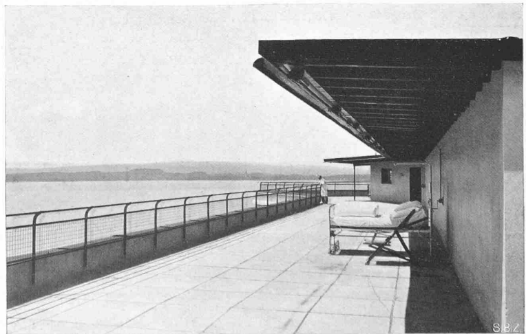
Abb. 3. Solarium auf dem neuen Bettenflügel, Blick gegen Westen
