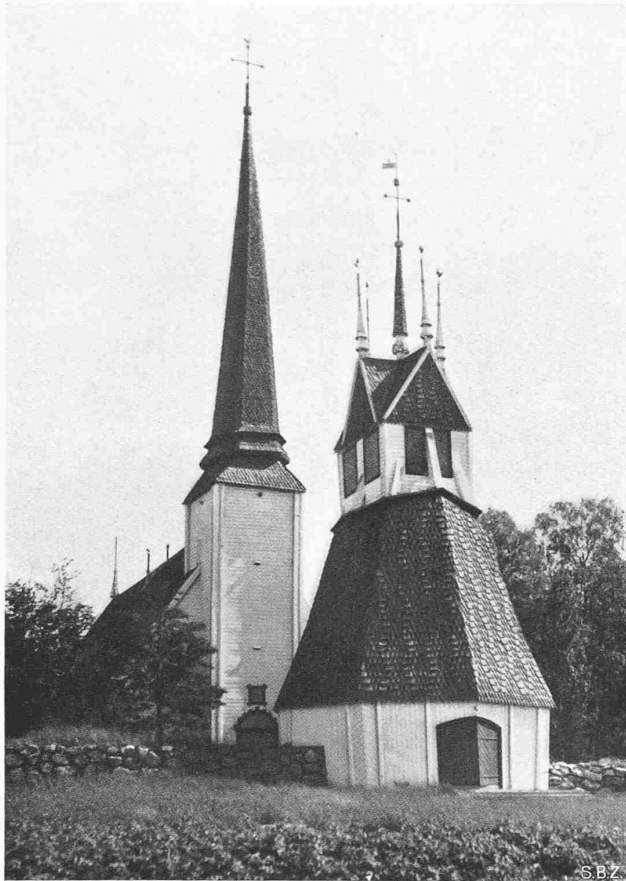
Abb. 3. Holzkirche in Tornio, erbaut 1684/86, gut erhalten
