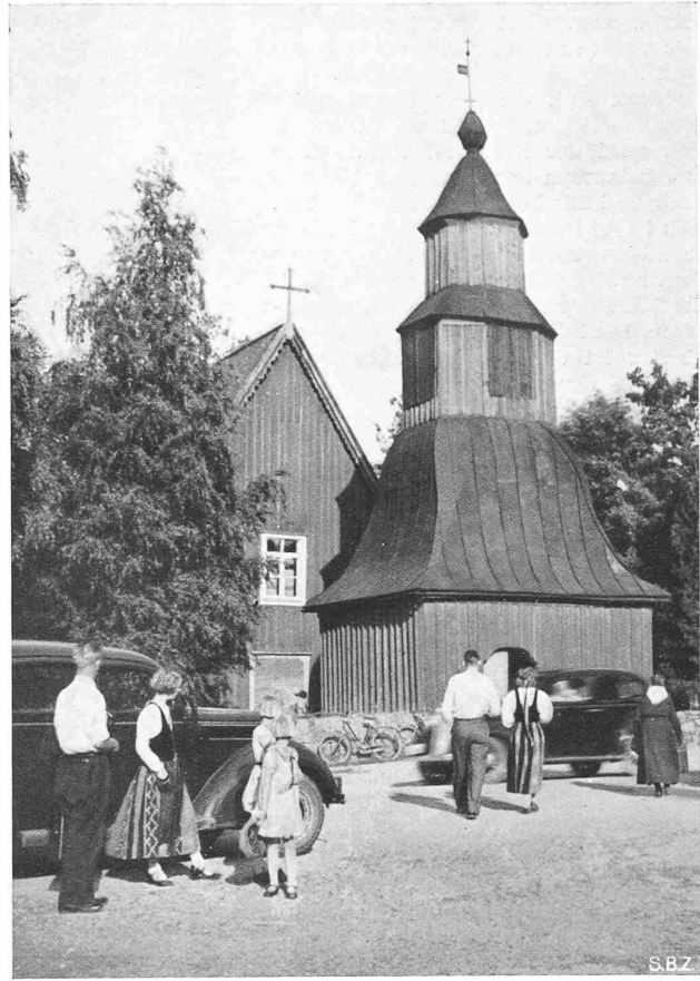
Abb. 4. Kirche Sammatti, 1754 (Verschindelung durch Blech ersetzt)
