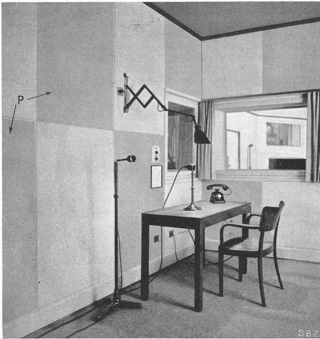
Abb. 22. Akustisch toter Raum mit perforierten Papatexplatten P
