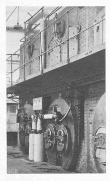
Abb. 4. B. B. A.-Dampfspeicheranlage mit zwei Reserve-Tischbeinkesseln
