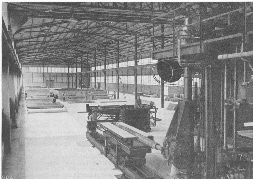
Abb. 9. Neue Rohrfabrik Niederurnen: Stahlkonstruktion mit Eternit-Deckung und -Wandverkleidung
