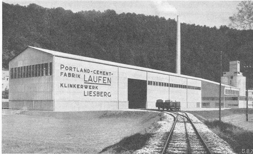
Abb. 6. Mit Welleternit verkleidete Stahlkonstruktion; Gewicht der Verkleidung 16 kg/m 2
