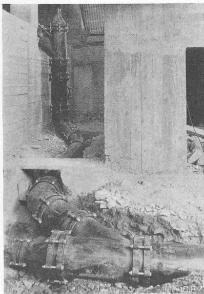
Abb. 17. Kombination von Eternit und Guss-Formstücken im Kantonsspital Chur
