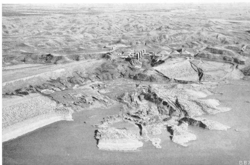
Abb. 11. Dammbruch am Fort Peck-Damm (28. IX. 1938), kurz vor Vollendung des Dammes
