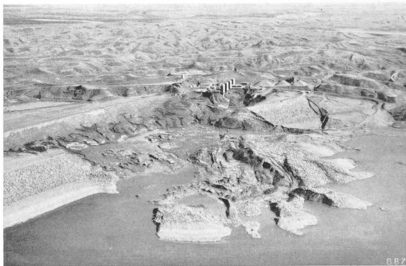
Abb. 11. Dambruch am Fort Peck-Damm (28. IX. 1938), kurz vor Vollendung des Dammes
