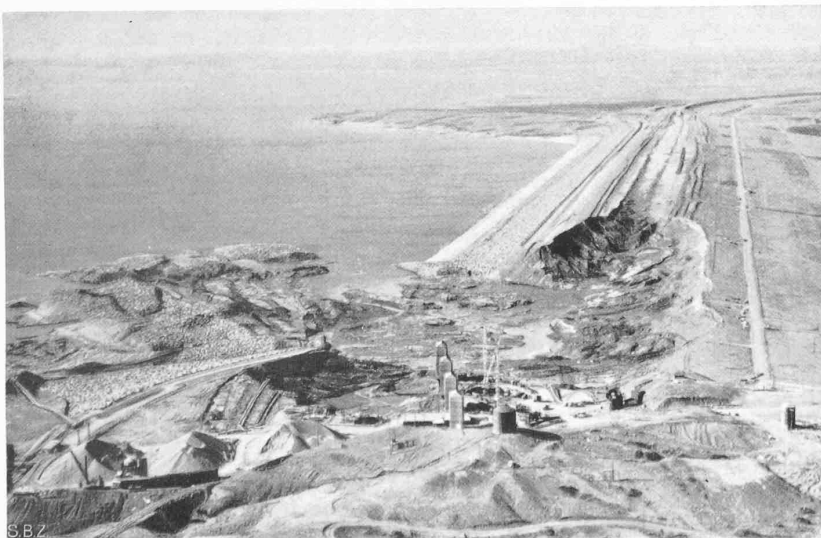
Abb. 12. Dammbreach am Fort Peck-Damm; wasserseitige Böschung 1:4
