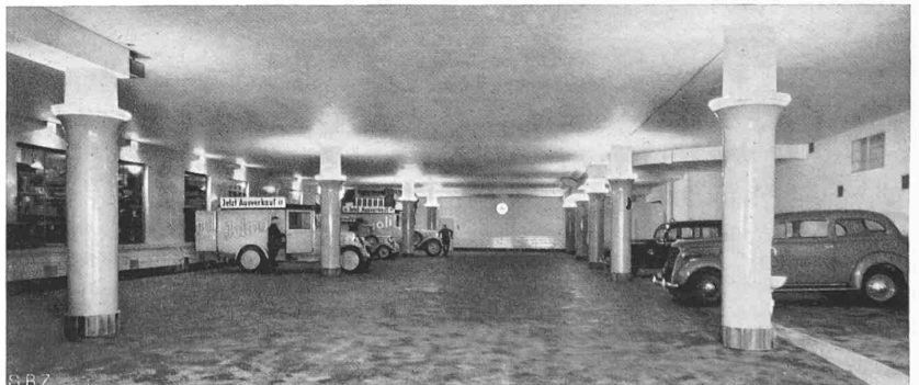
Abb. 15. Die Autohalle für den Warenversand im 1. Untergeschoss
